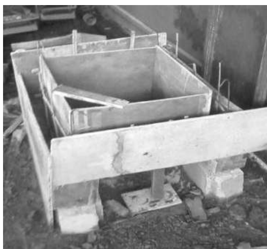
Gambar 3 Cetakan tungku dari kayu lapis
